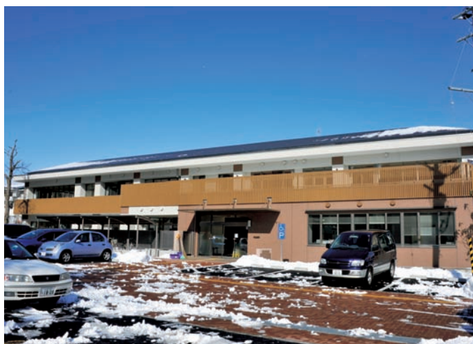
北山市民センター改築オープン（平成23年1月）
